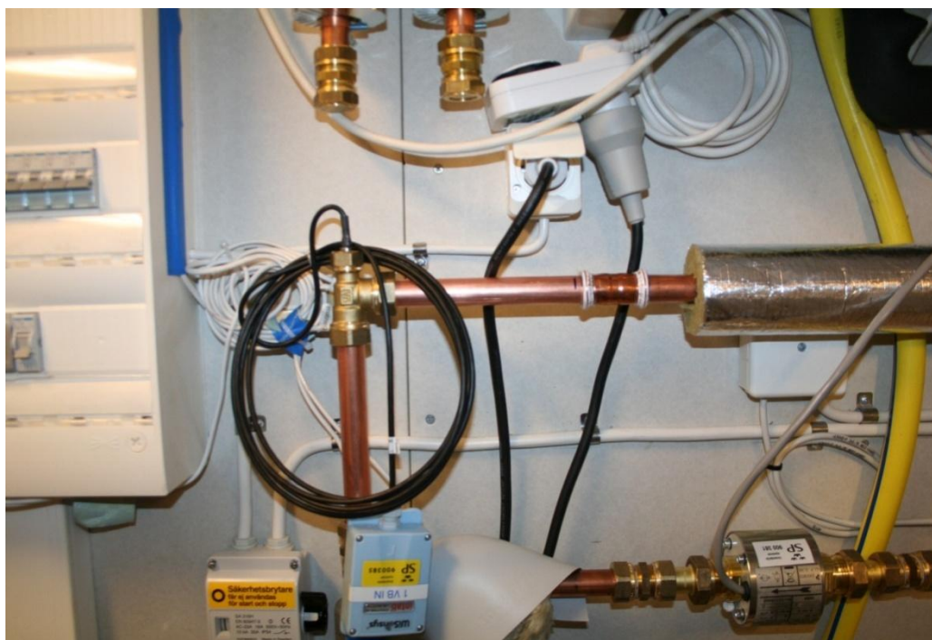
Figur 3.4-1 Exempel på placering av givare för temperatur före isolering av givaren. Den blå lådan är en temperaturlogger. Pt-100 givare för mätning av värmebäraren är i det här fallet installerad där det tidigare satt en 22 press-koppling. Kopplingen ersattes med T koppling 22×22×15 och en förminskning 15×10 för Pt-100 givare.
