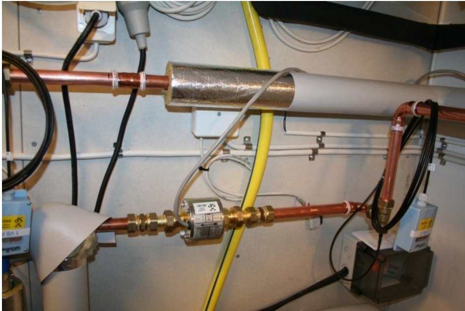
Figur 3.4-2 . Exempel på installation av flödesgivare före isolering. Längst ned till höger i bild syns en låda (kapsling) med inbyggd elenergimätare och pulslogger. För övrigt visas även den andra Pt100-givaren med dess temperaturlogger.
