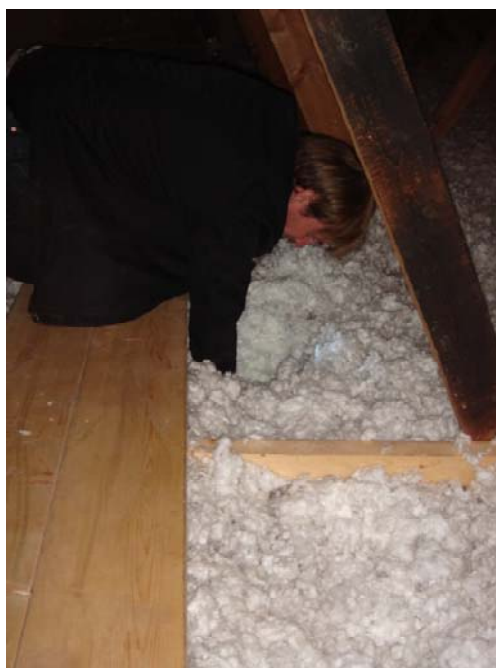
Figur 10: Uppskattning av isoleringstjocklek.
