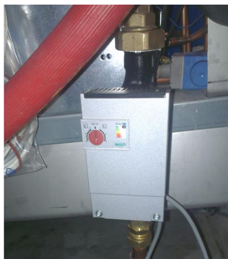
Figur 24: Kapacitetsreglerad VåV-pump samt dess regulator.
