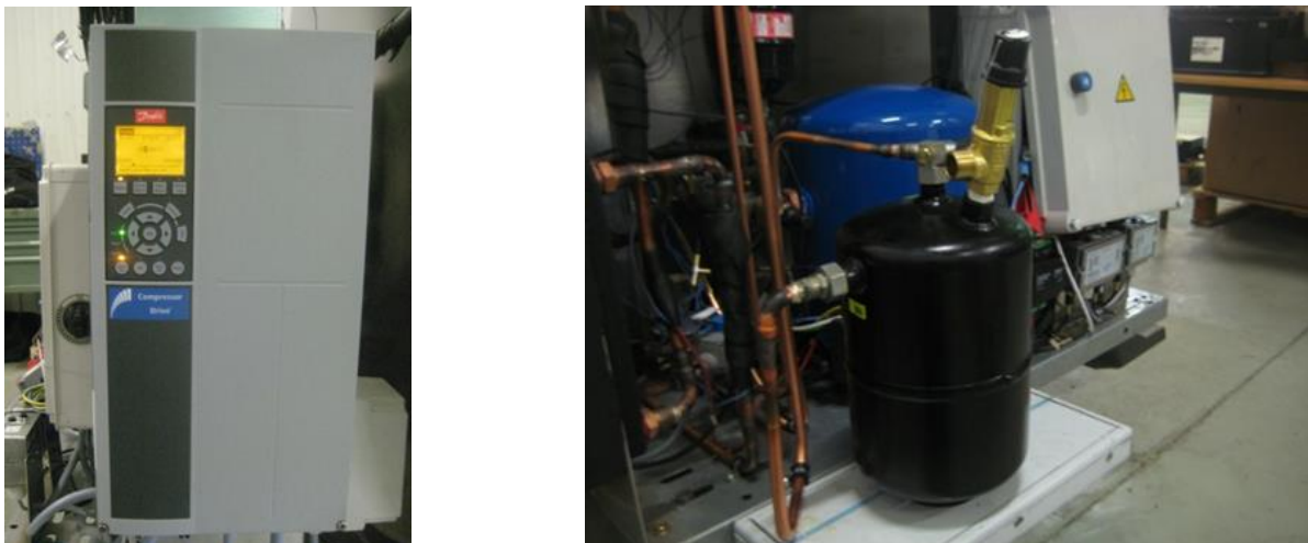
Figur 26: Frekvensomformare (Danfoss) och kompressor (Maneurop).
