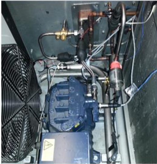
Figur 42: Aggregatets insida med kompressorn i mitten (tv) och baksida med förångaren i förgrunden (t.h).
