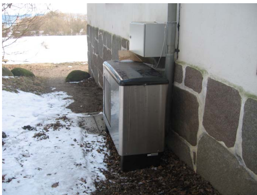
Figur 4. Uteluftvärmepump som används i kombination med solfångare. Foto: E. Kjellsson.
