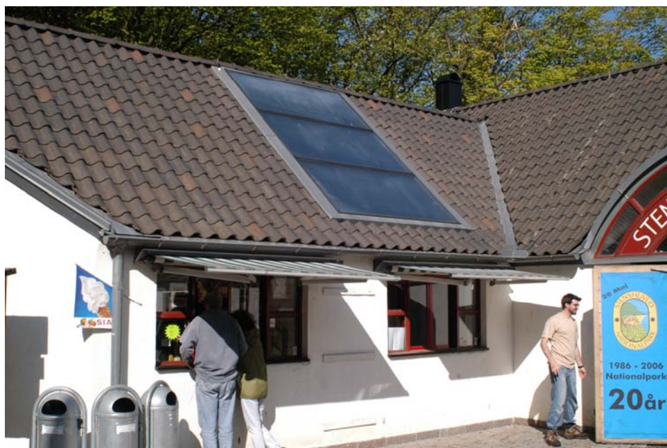
Figur 2. Solfångare som används i kombination med värmepump på besökscentret vid Stenshuvuds Nationalpark. Foto: E. Kjellsson
